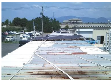
□事務所の屋根への断熱塗装の実施
