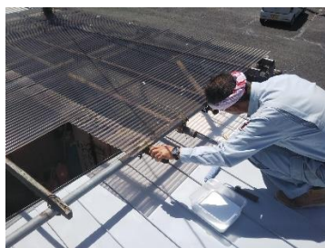
□事務所の屋根への断熱塗装の実施
