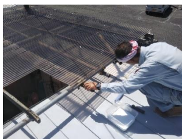
□事務所の屋根への断熱塗装の実施
