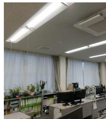
本社各部屋照明のLED化
